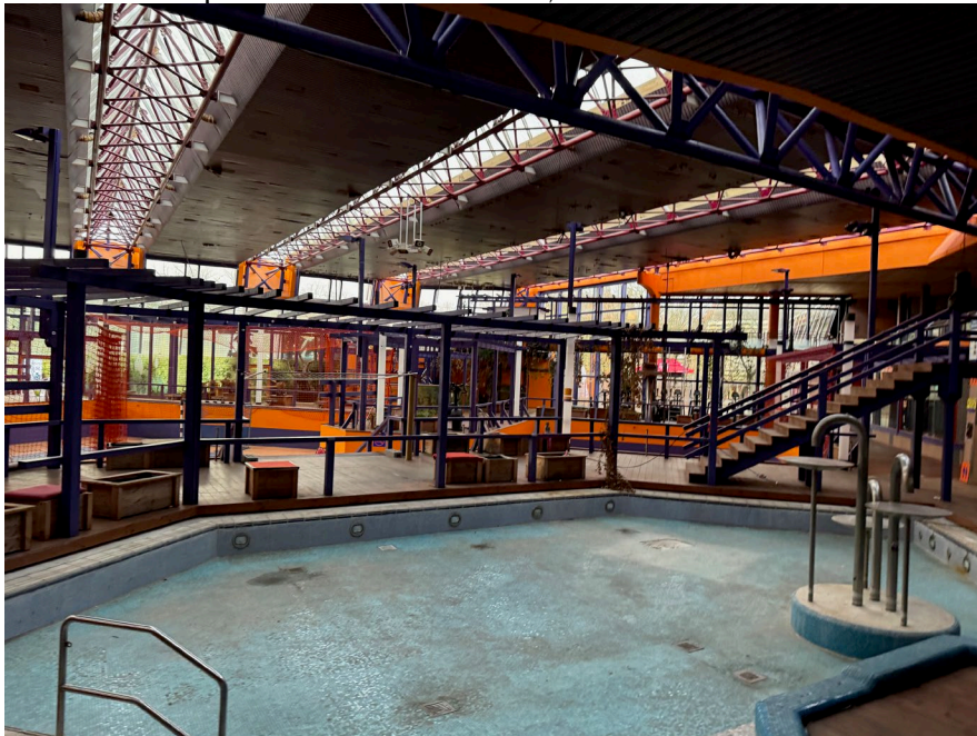
Abb. 2: Messpunkt 2: Hallenbereich, Großer Pool
